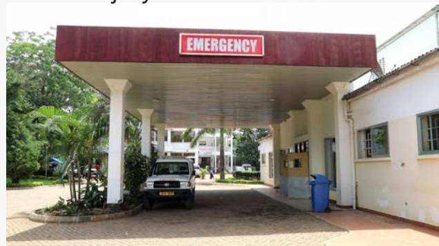
Jengo la huduma ya dharura KCMC
